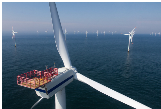
Foto 1 – Parco eolico offshore
