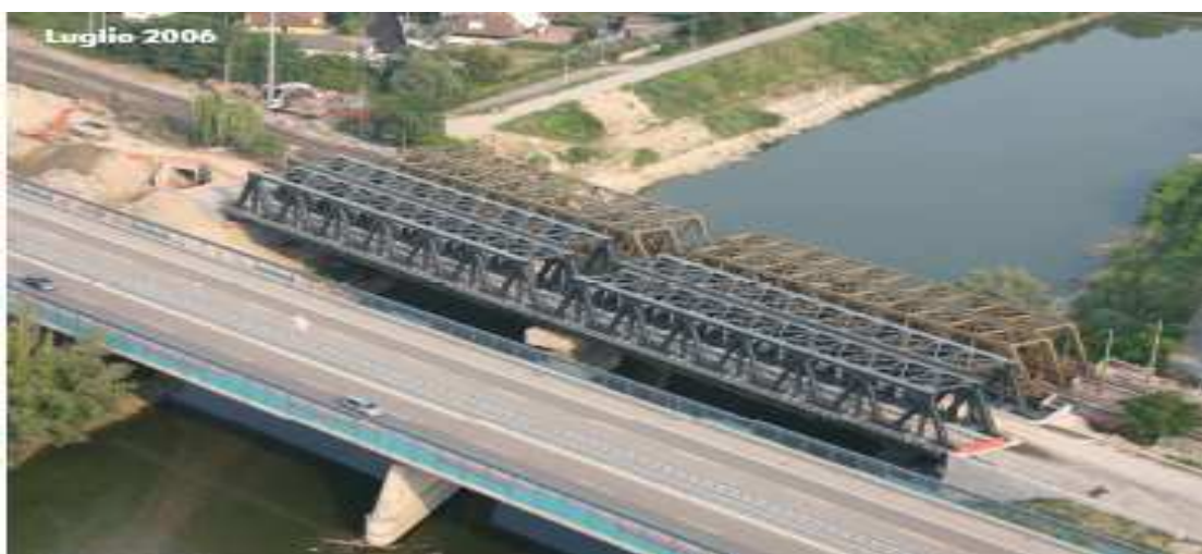
FOTO 2: PONTE SUL FIUME BRENTA
